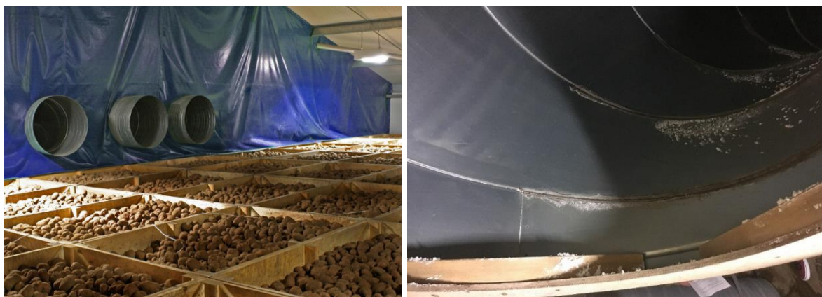
Foto. 5 i 6 Krytycznymi miejscami w przechowalniach o składowaniu w paletach skrzyniowych o największym zanieczyszczeniu chloroprofmem (CIPC) jest system wentylacyjny
