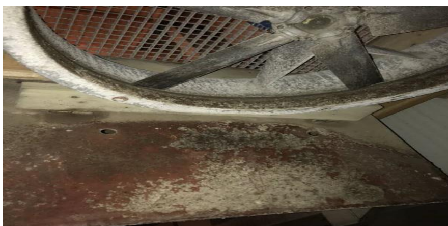
Foto. 3 Wentylator i jego drewniana osłona odwróconego przepływu powietrza ze złoгами stosowanego w przeszłości chloroprofamu (CIPC)
